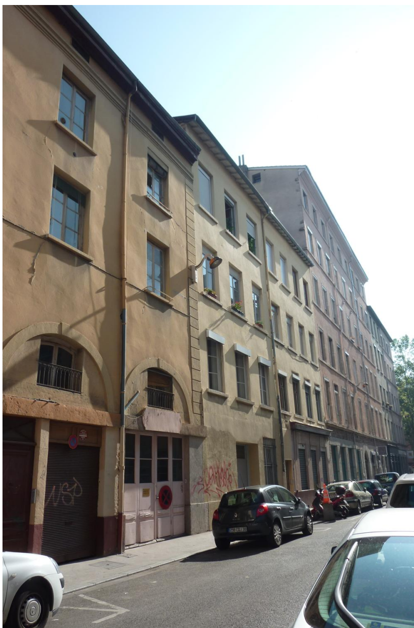
Vue d'ensemble de l'immeuble-atelier
