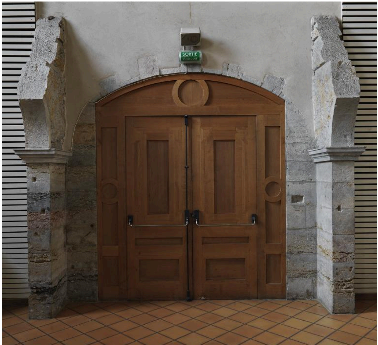
Porte d'entrée, vue intérieure
