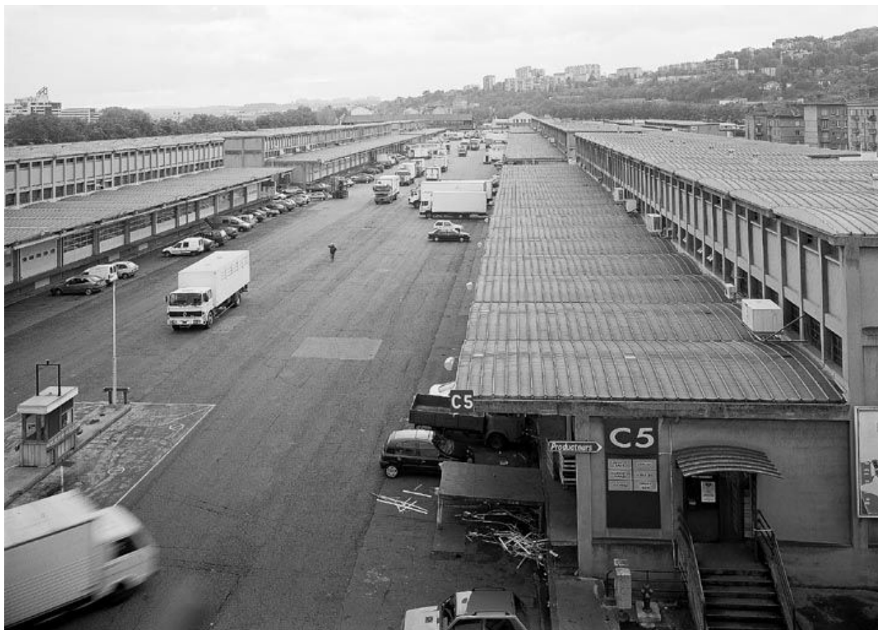
L'allée centrale depuis le toit-terrasse du bâtiment administratif
