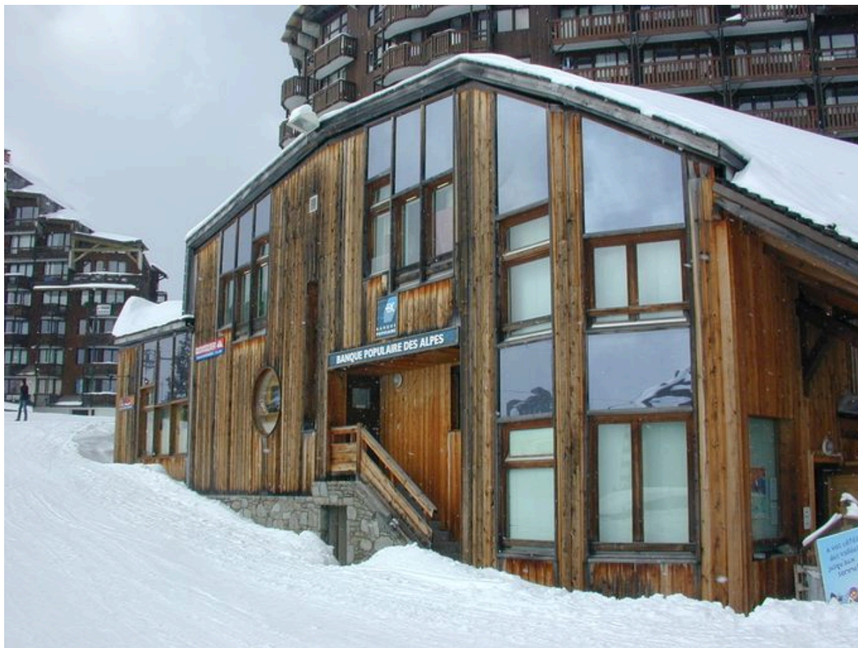
Façade sud-ouest, rue des Traîneaux
