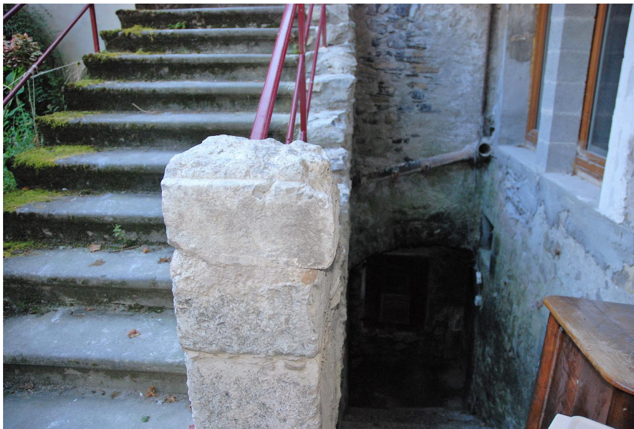
Maison, immeuble, 100 rue Louis Blanc-Pinget (2018 E1 1797). Elévation sur cour, escalier d'accès aux caves et aux étages.
