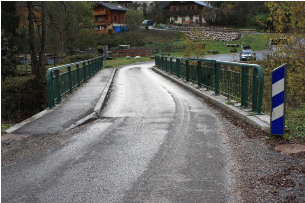
Pond de Sous Saint-Jean, chaussée et gardes corps
