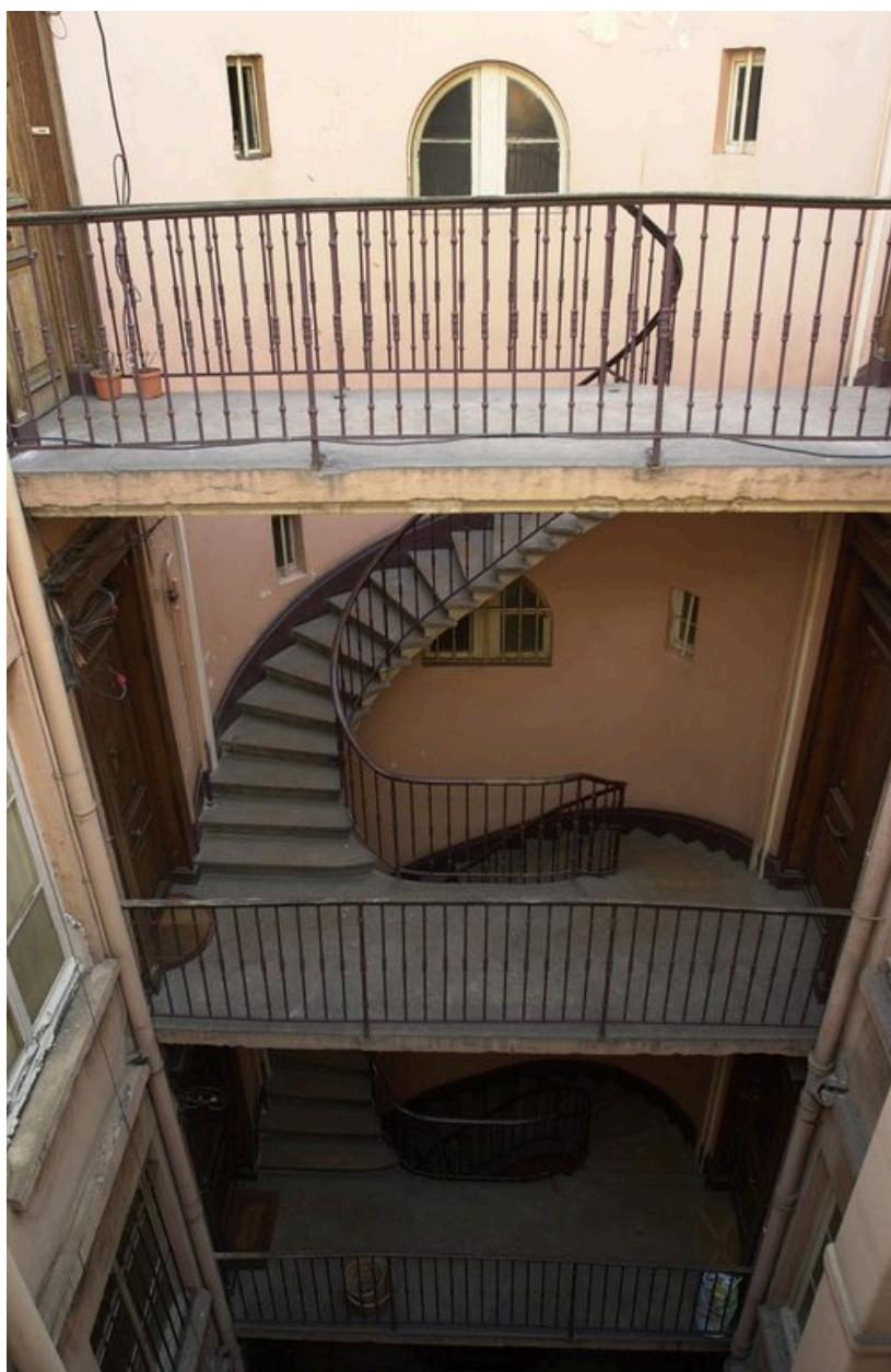
L'escalier sud : dernières volées
