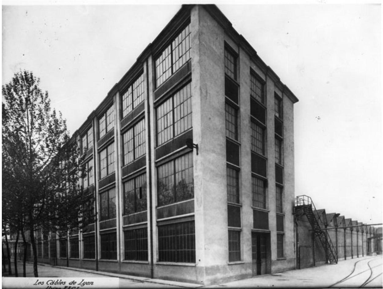
Immeuble conditionnement et expéditions, image d'archives société Nexans
