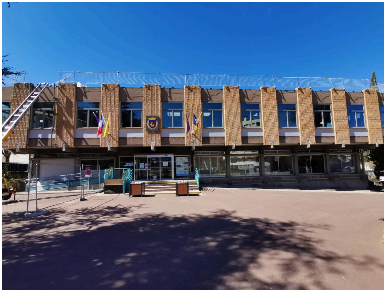
Façade antérieure de l'hôtel de ville de Royat, avant travaux.
