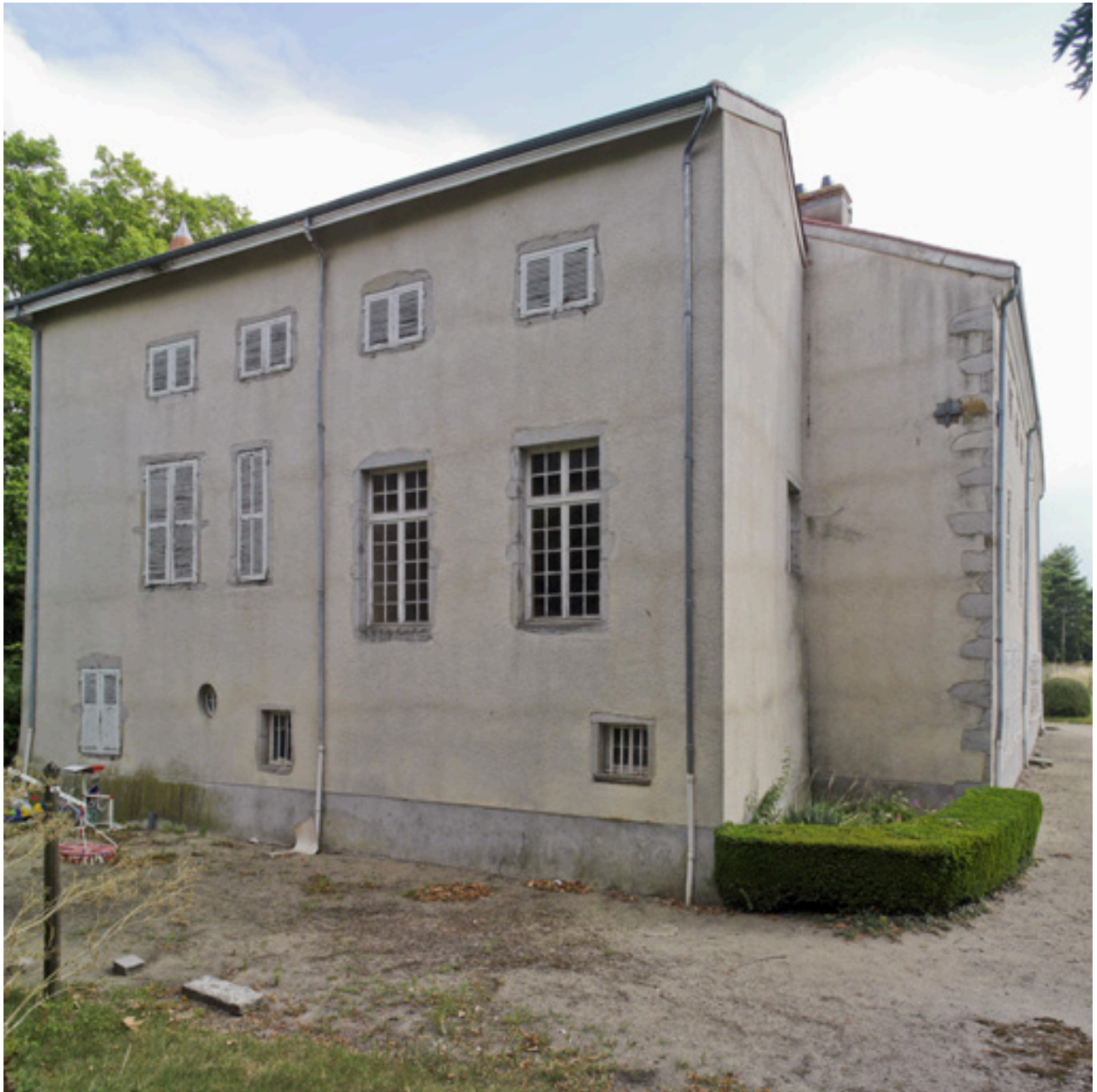
Vue de l'aile nord, élévation nord (partie ouest).
