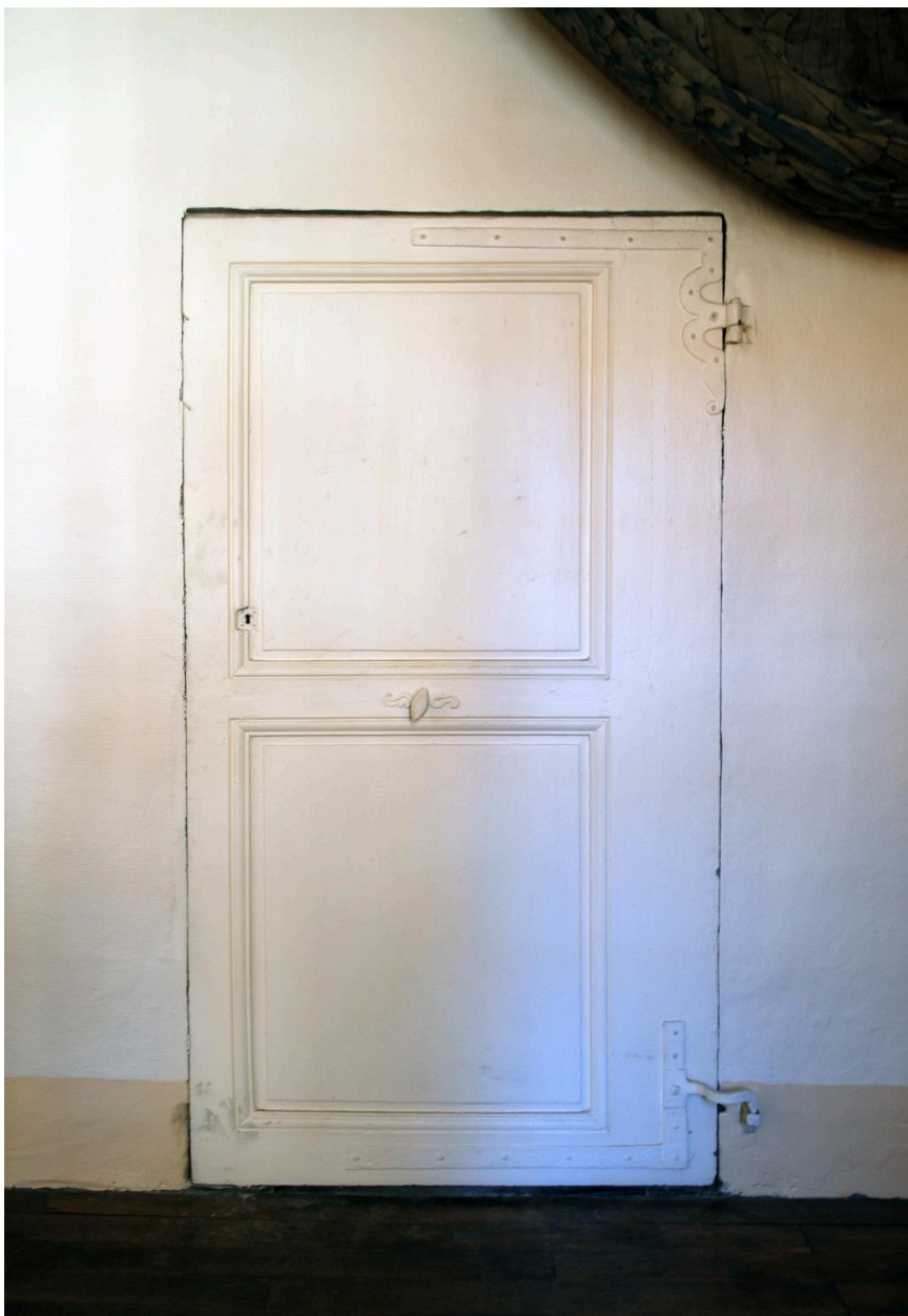
Bâtiment C, galerie des tapisseries : porte donnant accès aux tribunes est de l'église
