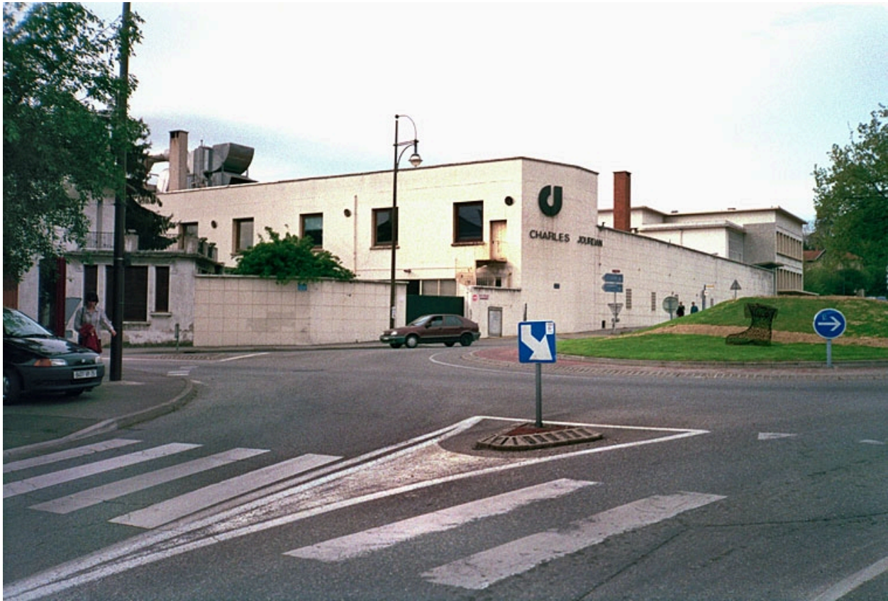
Façades sud et est
