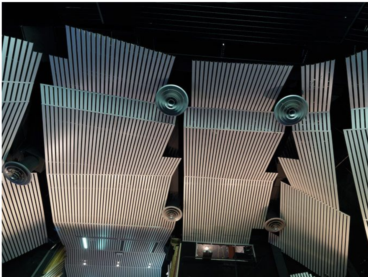
Le plafond accoustique
