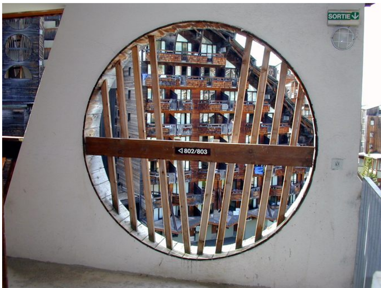
Détail d'une baie d'une coursive
