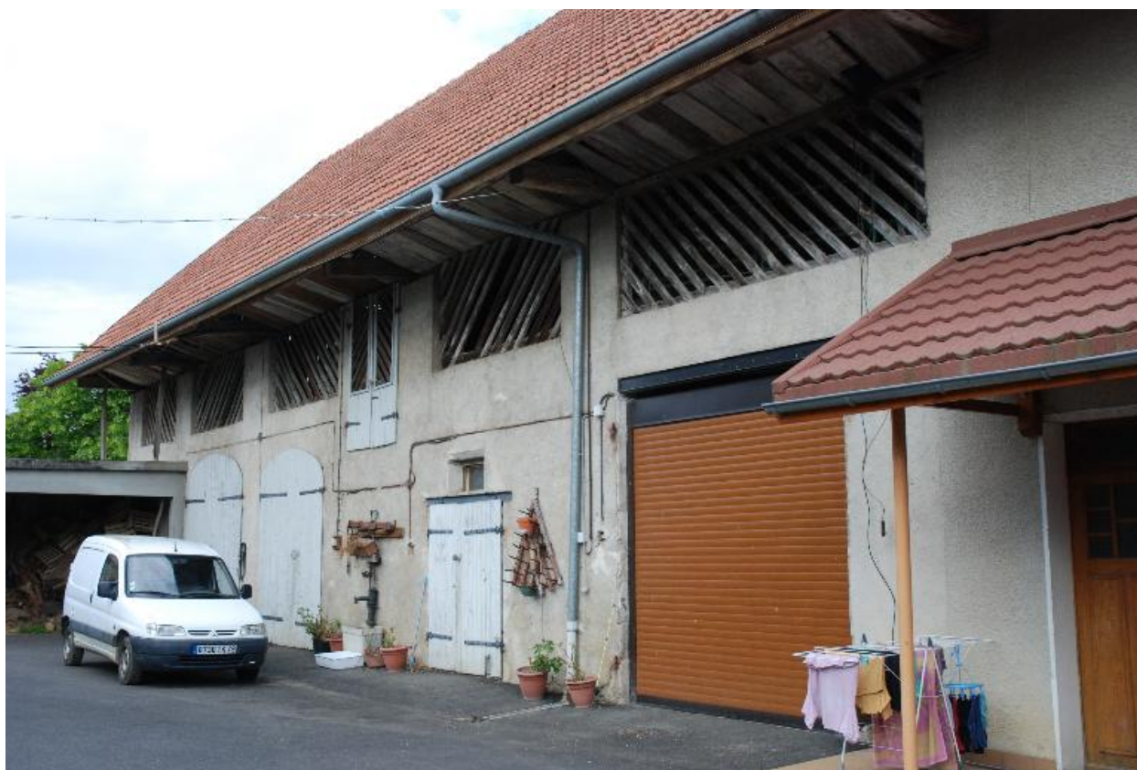
Vue d'ensemble de la grange-étable.
