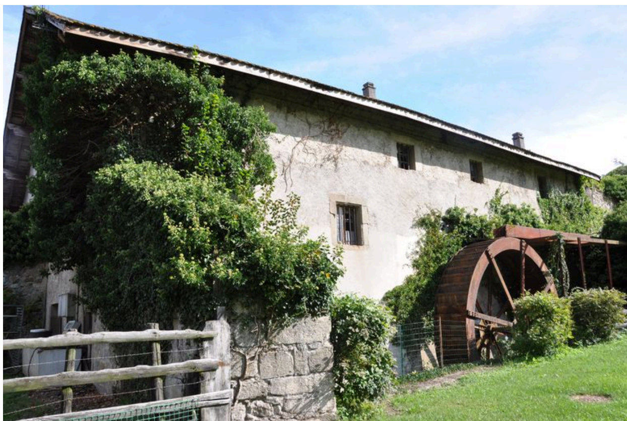
Façade latérale sud du bâtiment du moulin
