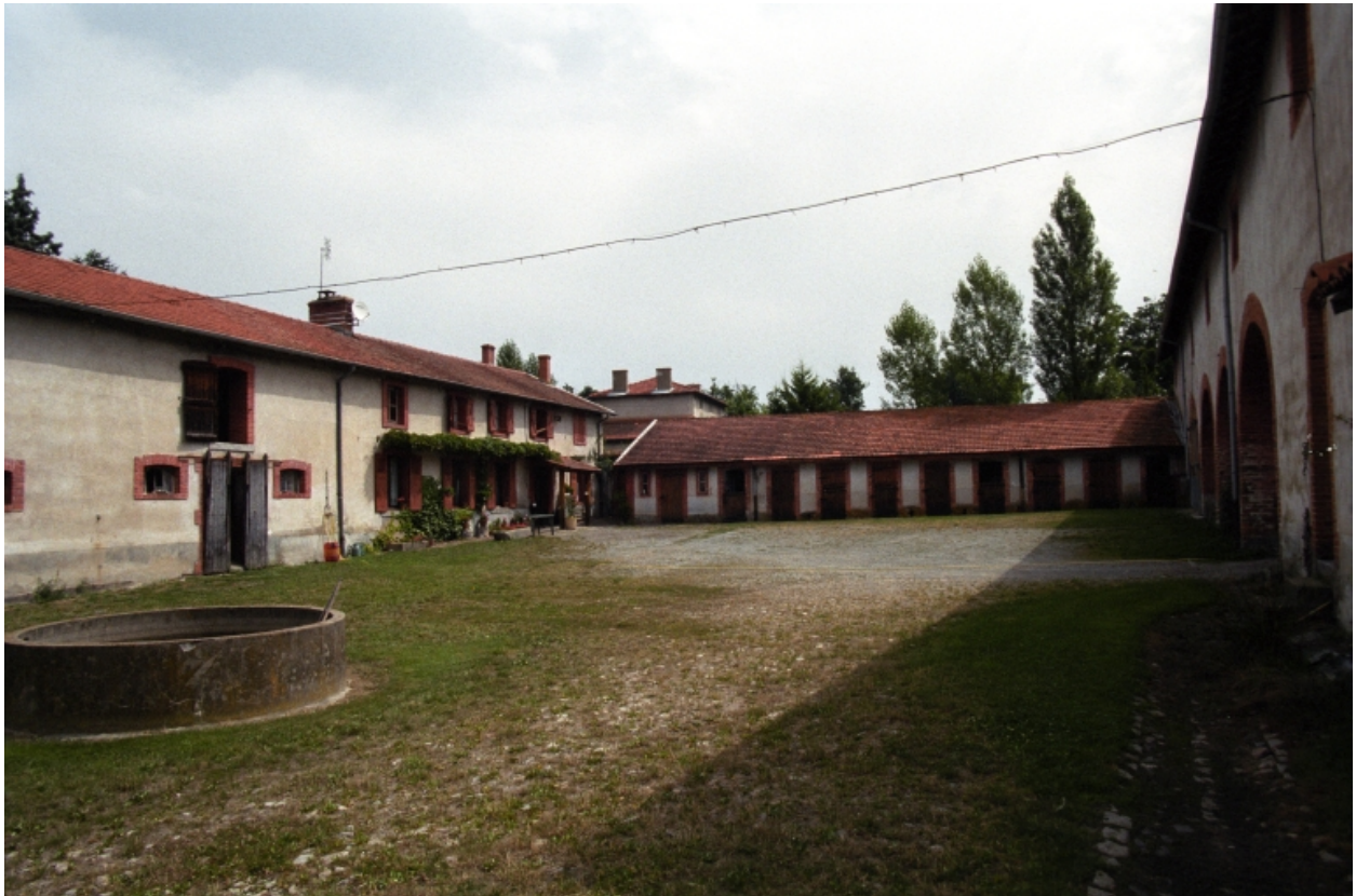
Vue d'ensemble de la cour depuis l'ouest.
