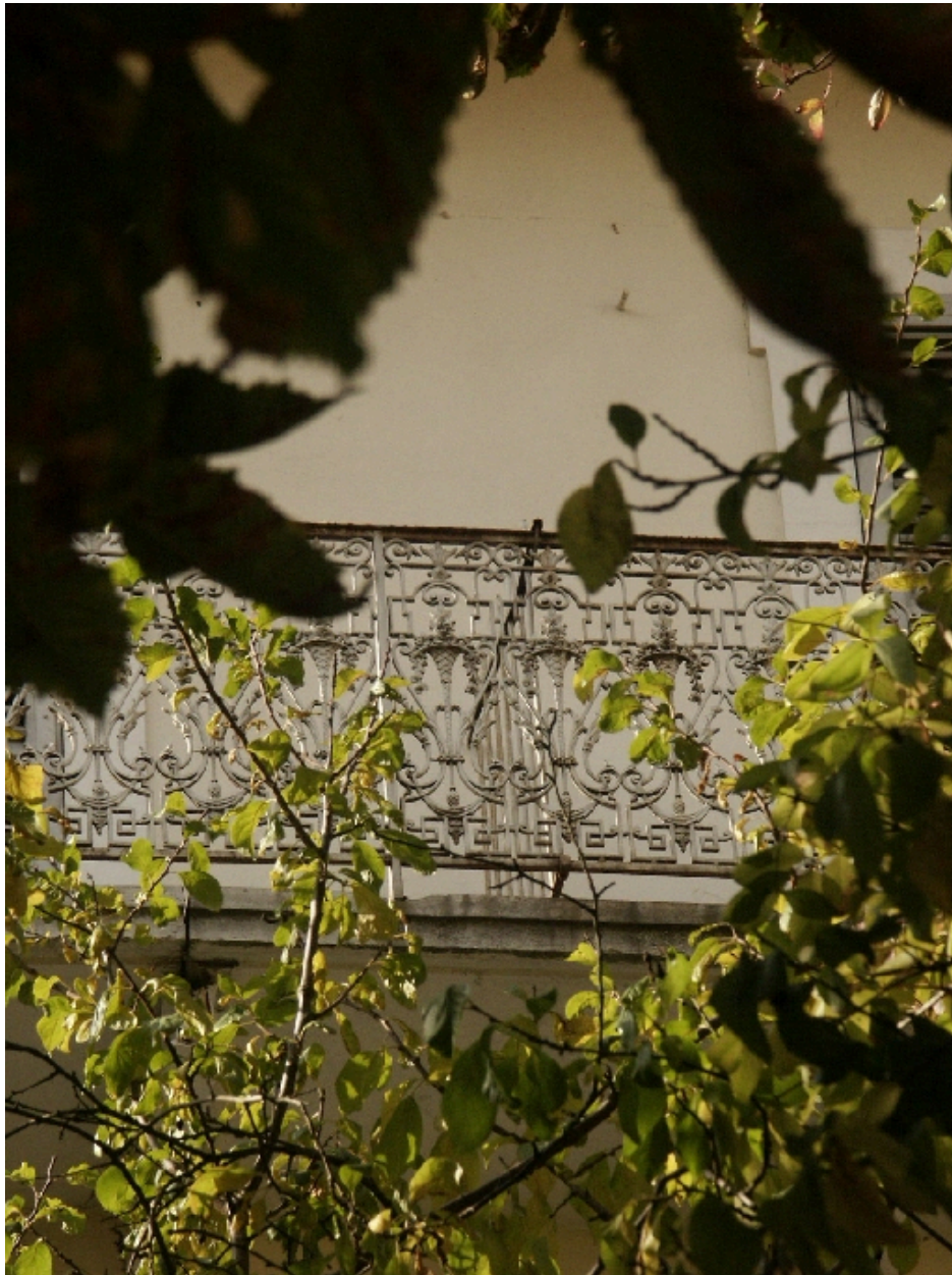
Aile nord : détail du balcon du 1er étage sur jardin
