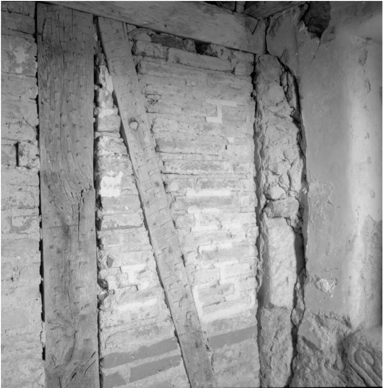
Logis prieural, vue intérieure des latrines, détail du mur de pan de bois et briques à joints rubannés.
