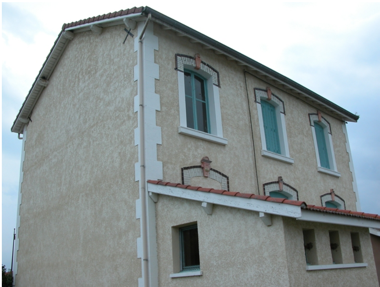
Vue d'ensemble de la façade arrière.
