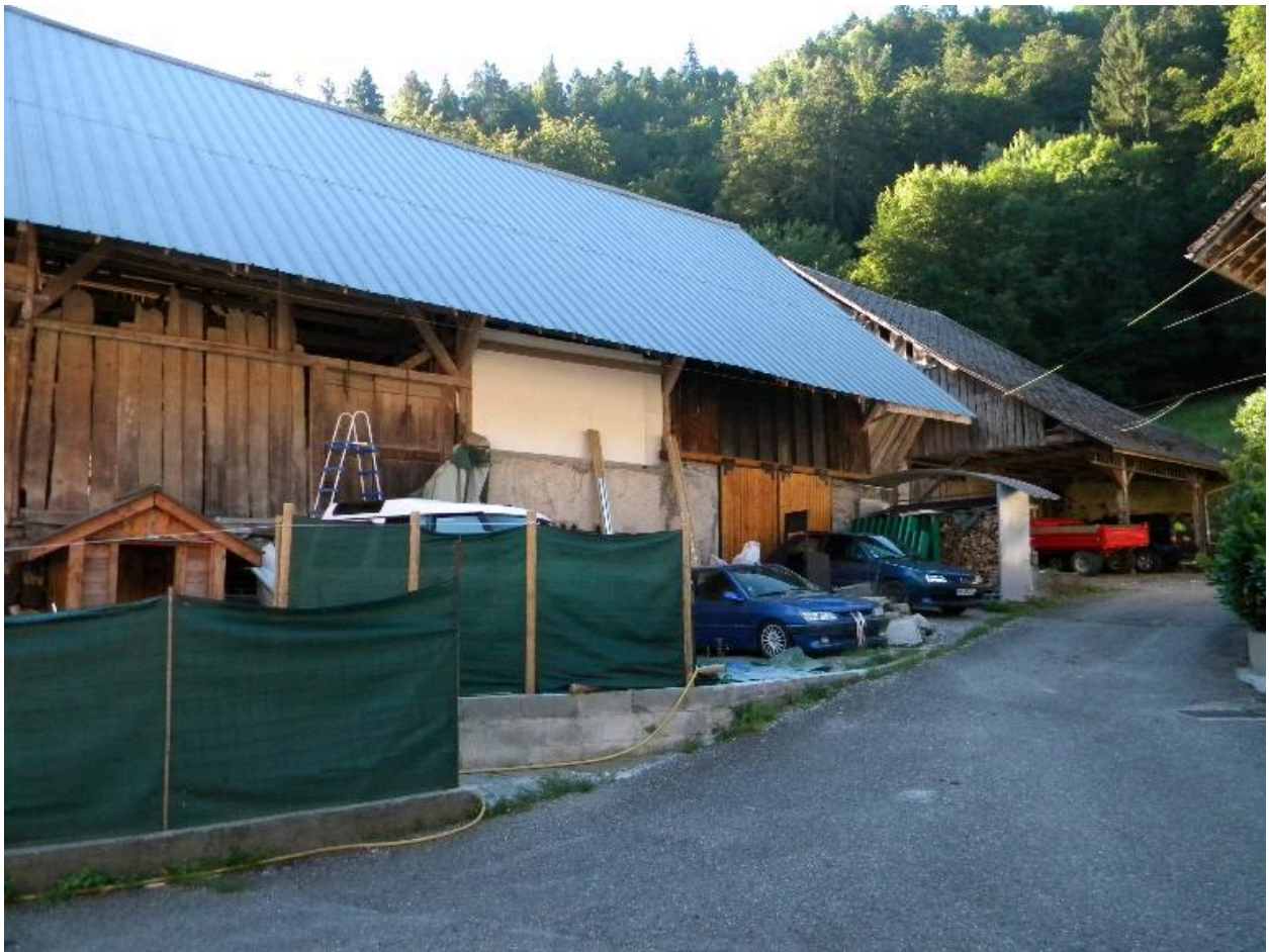
Vue de la façade principale d'une ferme à juxtaposition (2008 D4 871)
