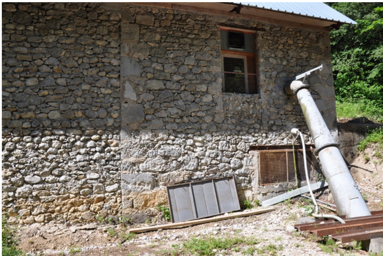
Détail de la façade sud avec le bâtiment de la première unité de production
