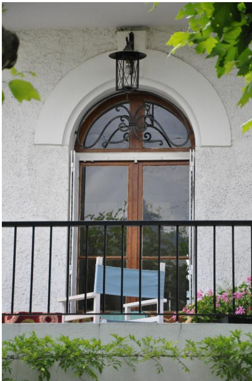
Détail d'une baie en plein cintre
