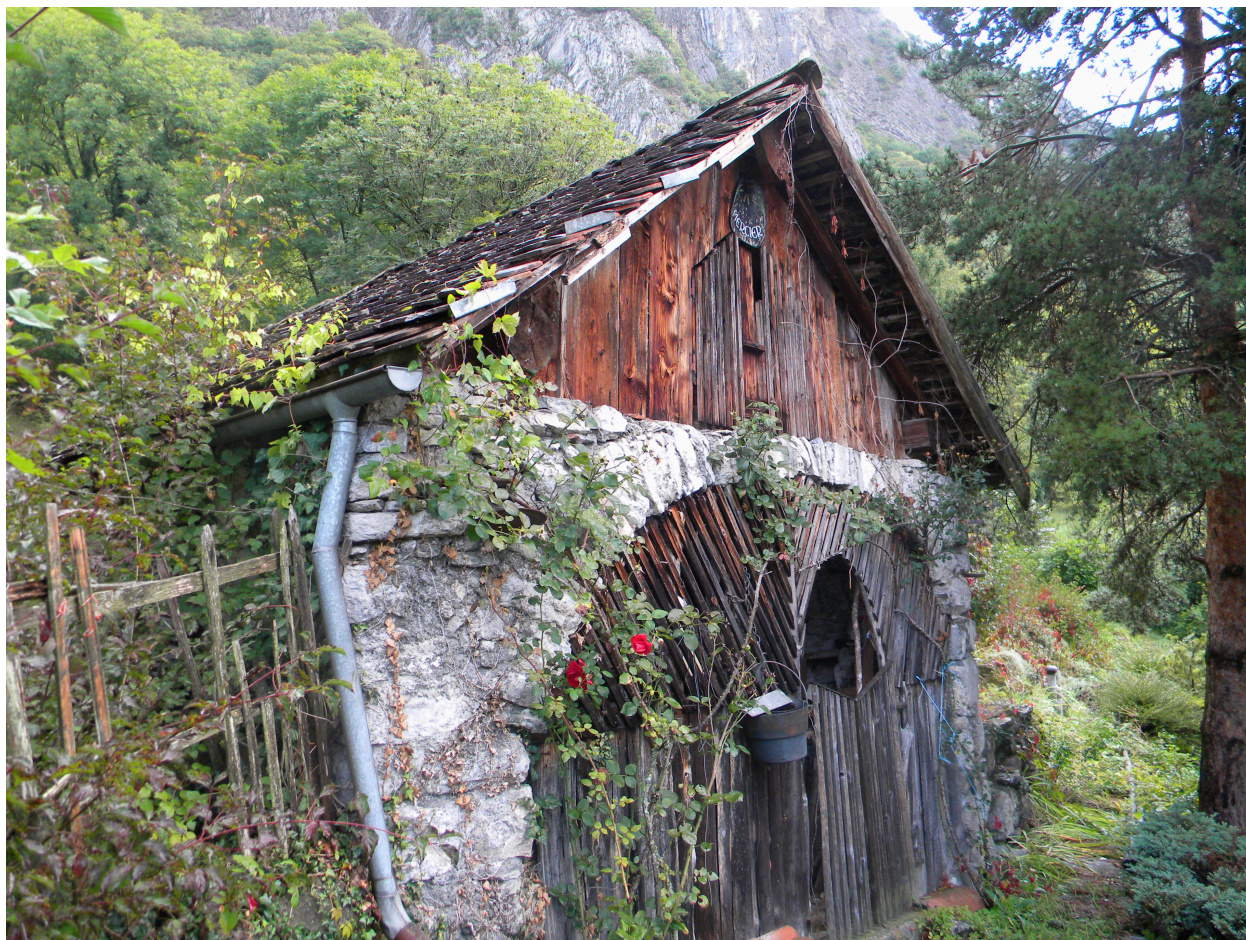
Vue de l'entrée de la salle du four.
