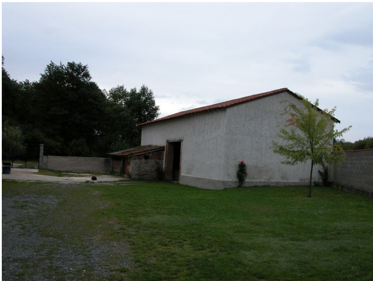
Vue de la grange.
