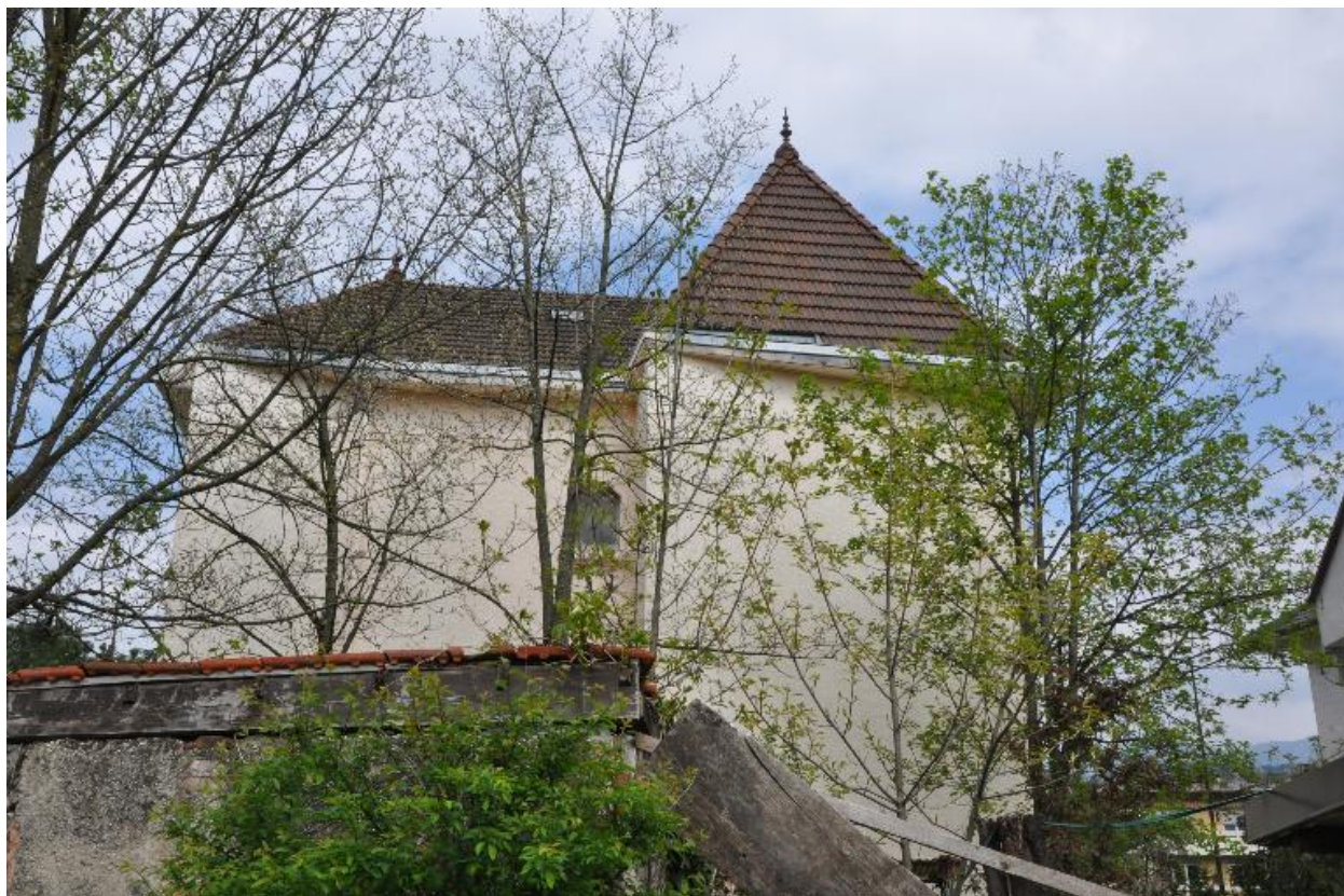
Vue depuis l'arrière
