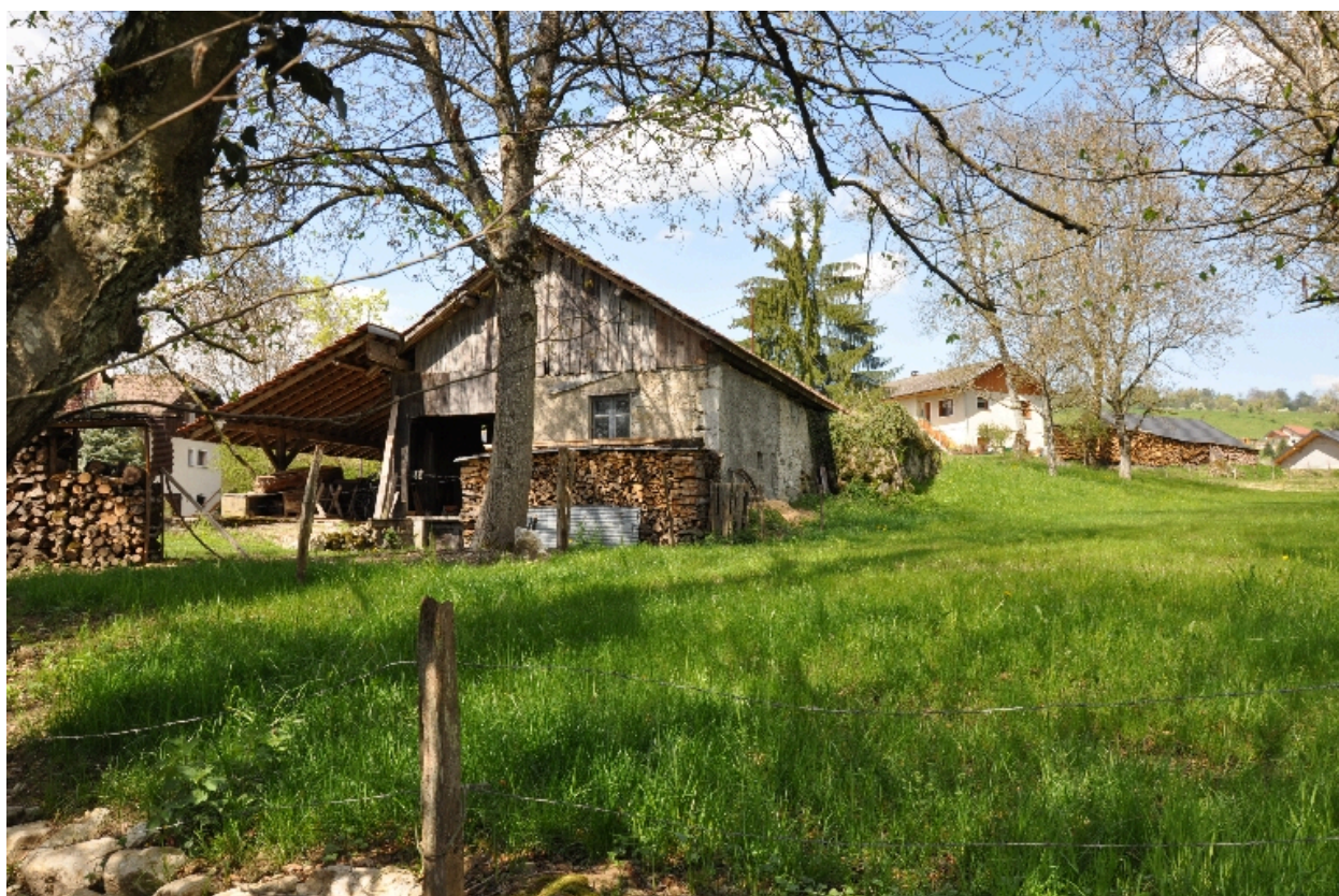
Vue depuis le sud-est.
