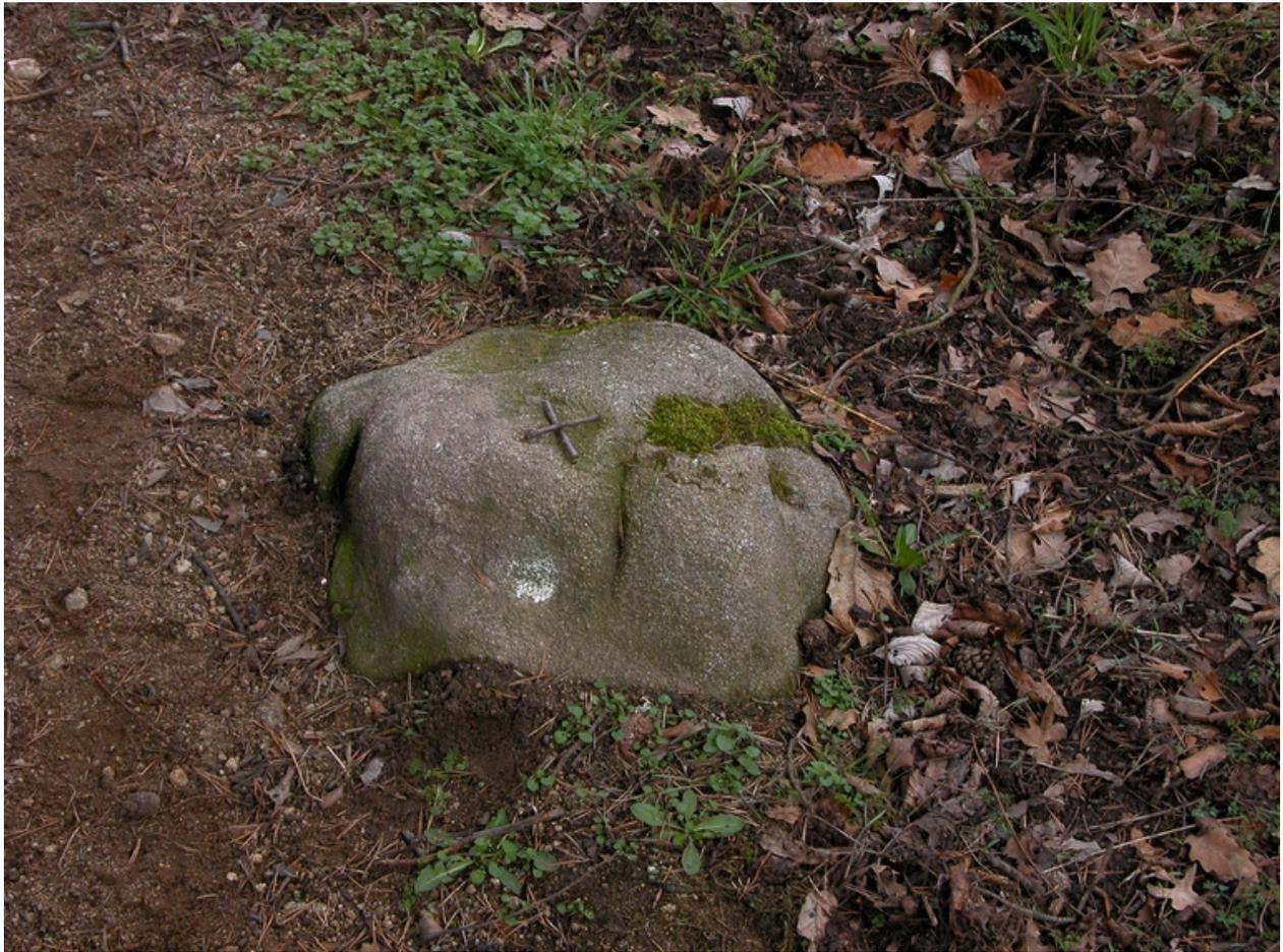
Borne dans le bois de Mont Dion (avec des brindilles pour matérialiser la croix indiquant l'orientation du bornage).
