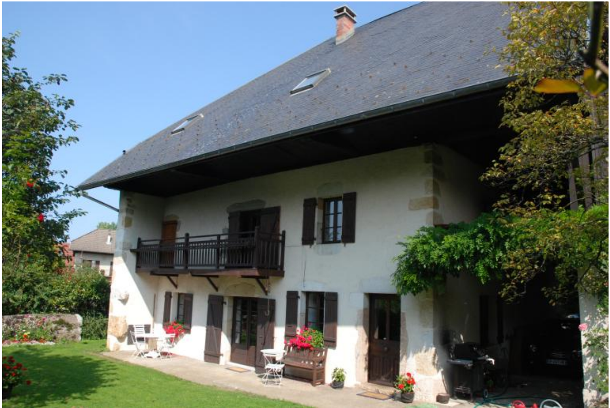
Viuz-Nord, C4 222, 1856, 1858, ferme. Vue d'ensemble de la façade principale sur cour, orientée à l'ouest.
