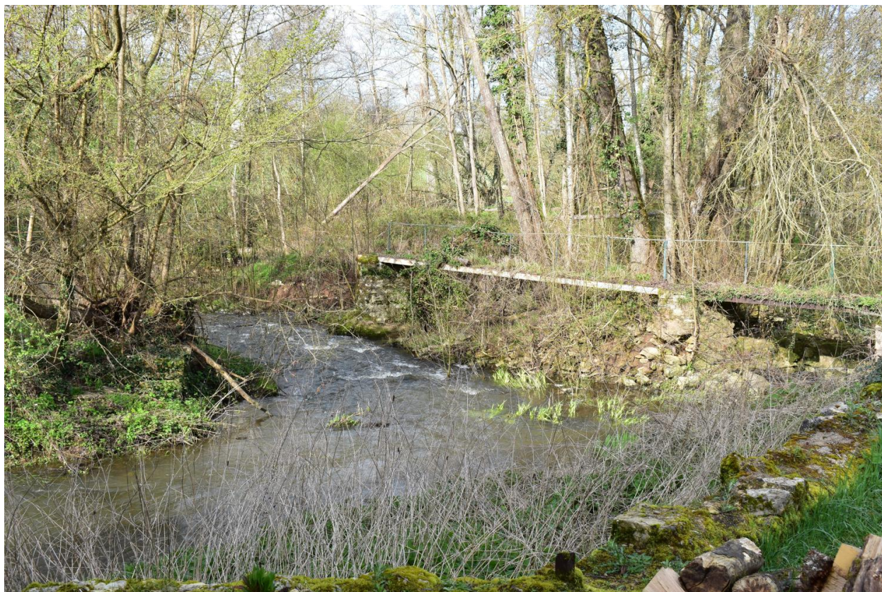
Vue en amont des aménagements hydrauliques subsistants .
