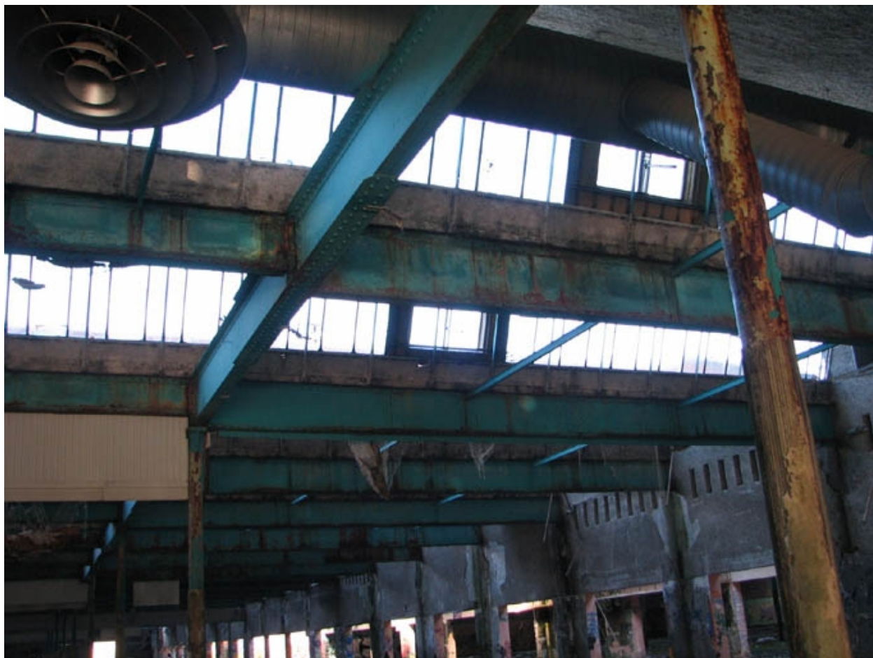
Vue intérieure des ateliers sheds
