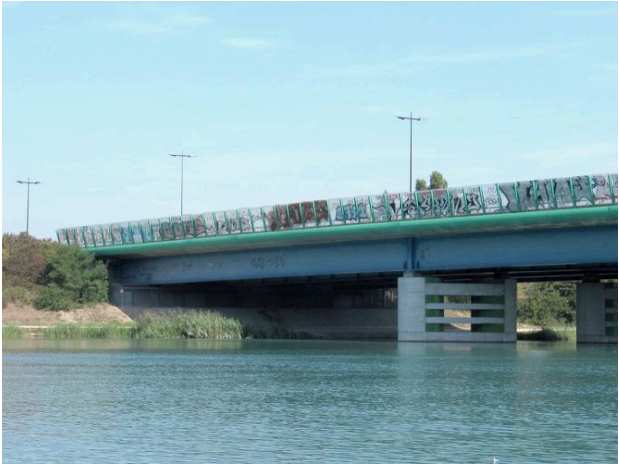
Vue partielle, travée et culée rive droite, face aval (depuis la rive gauche)
