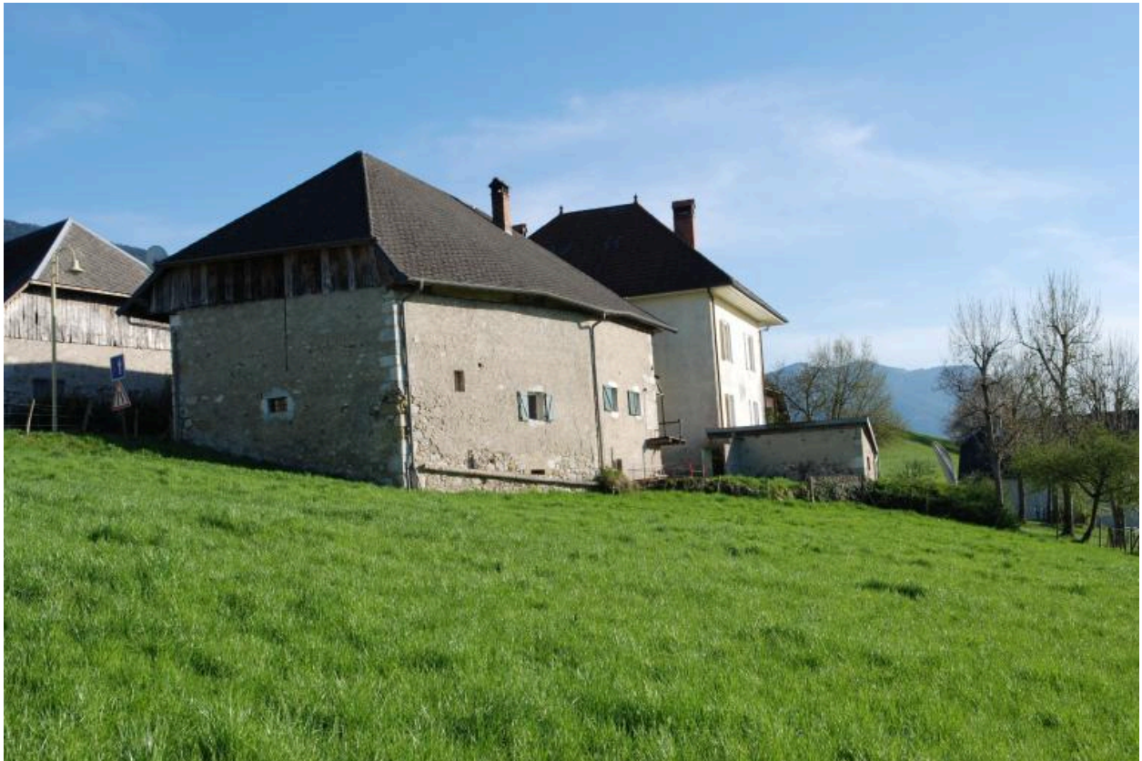
Vue d'ensemble arrière du bâtiment.
