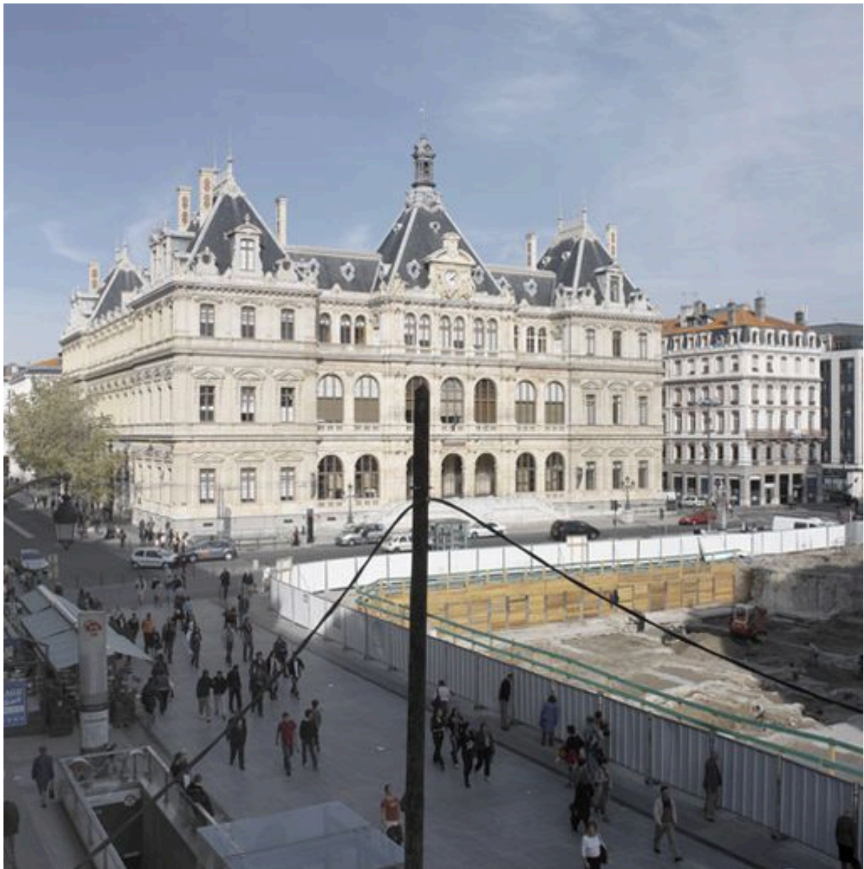
Vue d'ensemble depuis le sud-ouest, après la démolition du Grand Bazar
