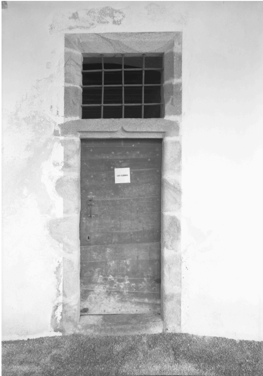
Corps de galerie, rez-de-chaussée, portique : vue de la porte de la troisième pièce du portique dite "les cuisines".
