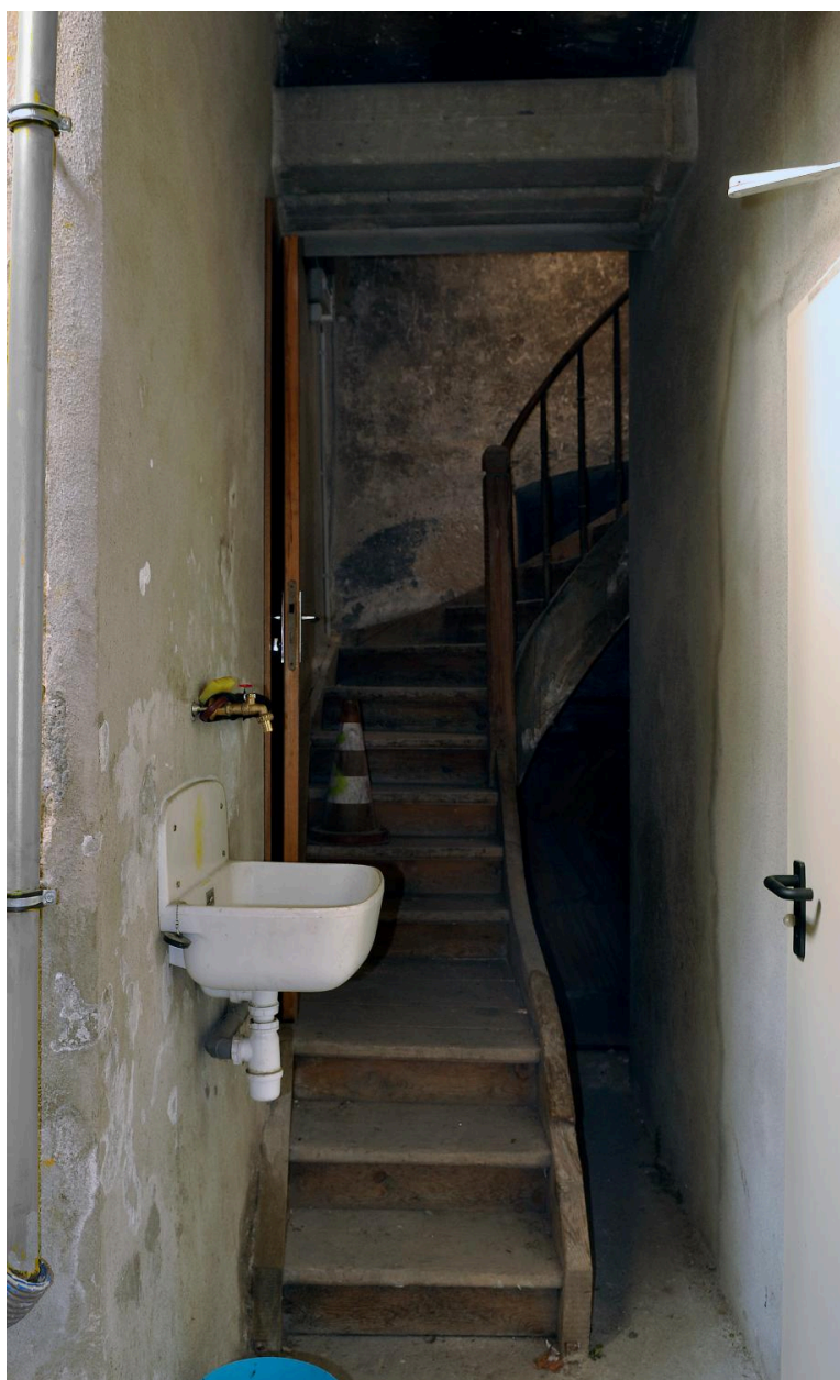
Ancienne sacristie, actuellement chaufferie : escalier montant à la tribune nord-est
