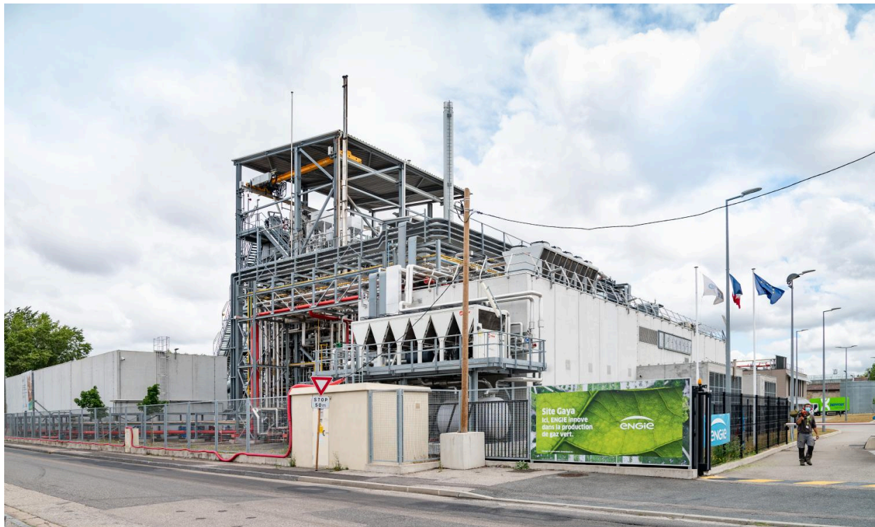
L'entreprise GAYA, Saint-Fons, 2021 (©Métropole de Lyon)
