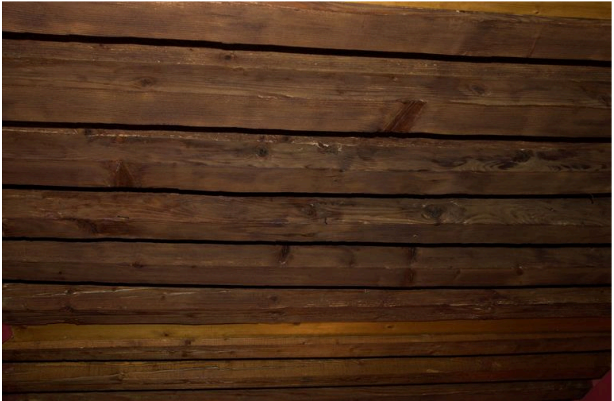
Détail du plafond à solives à l'étage
