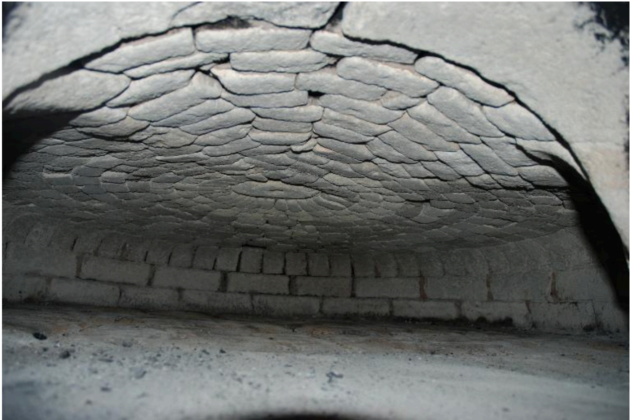
Vue intérieur du four à pain commun (2014 A5 553, 1073), non repéré : détail de la voûte du four.
