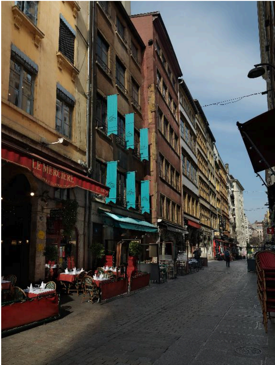
Vue de situation sur la rue Mercière (quatrième immeuble à partir de la gauche)
