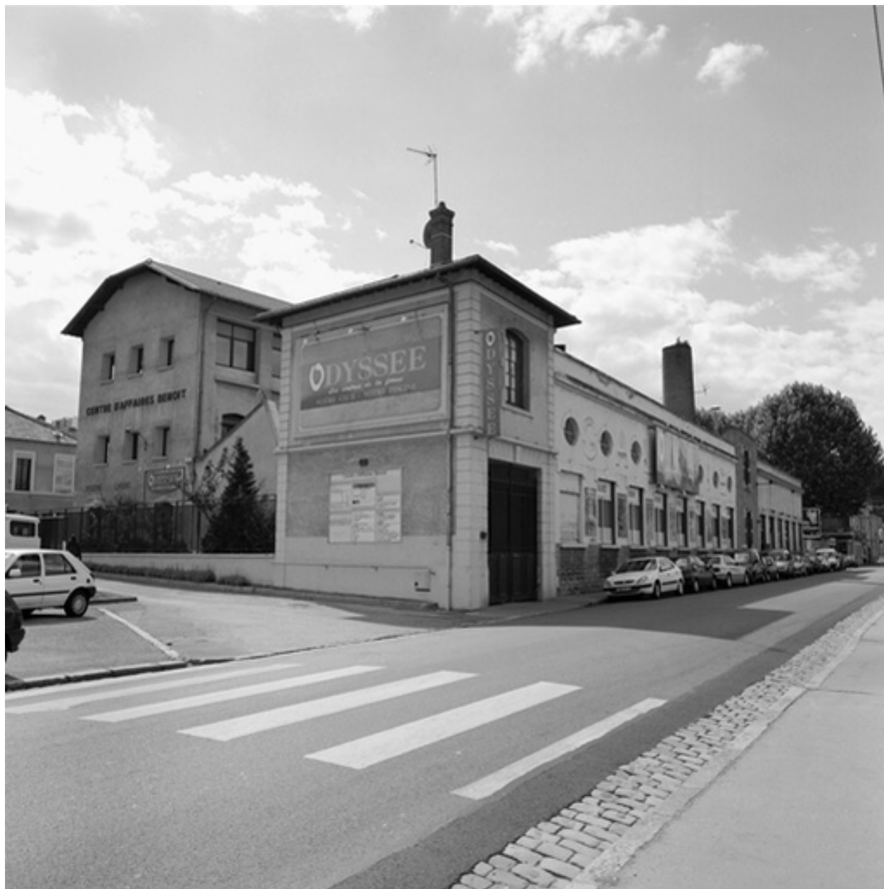
Vue d'ensemble nord-est
