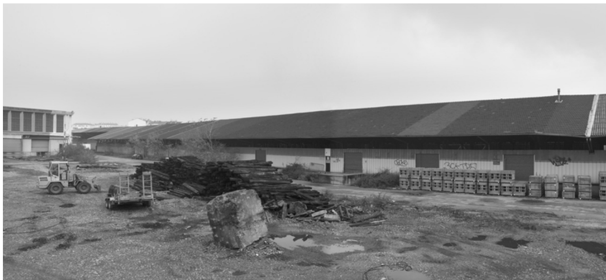
Vue sud, entrepôts latéraux
