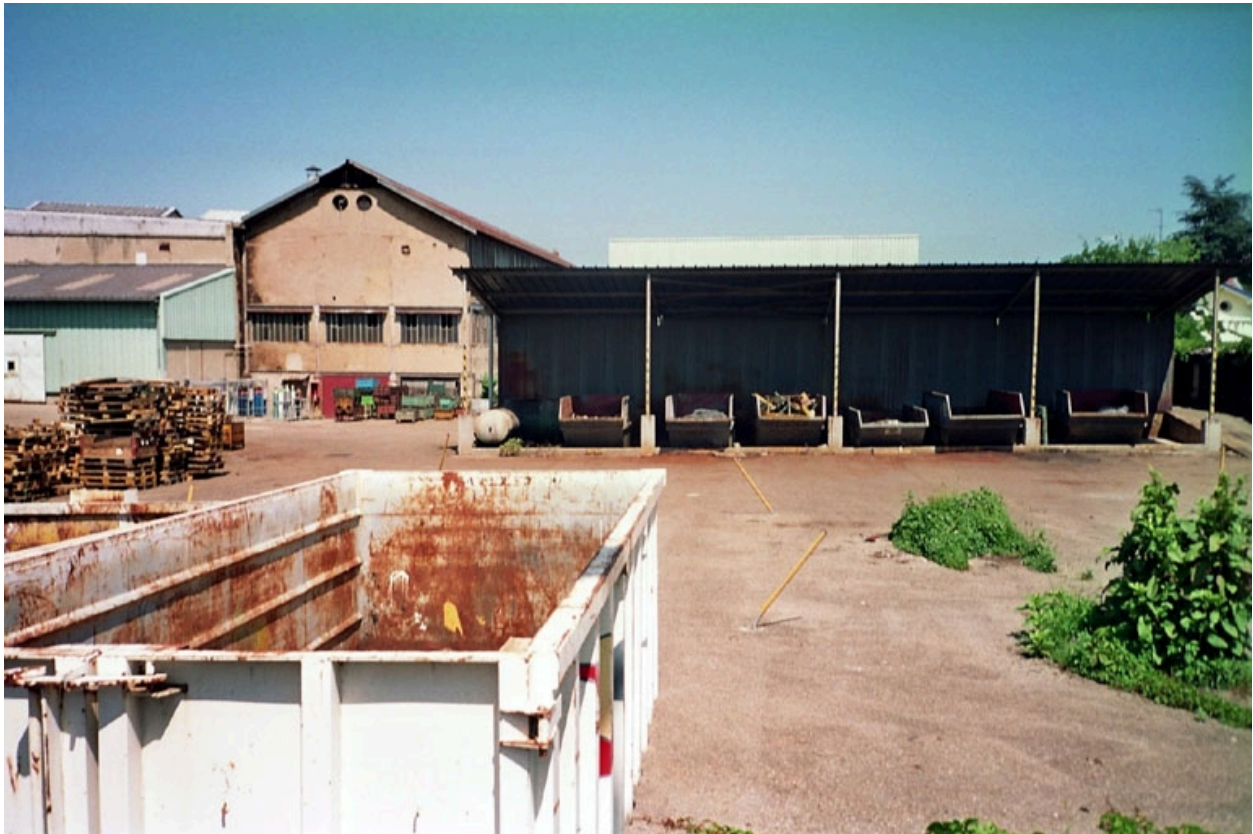
Vue d'ensemble ouest
