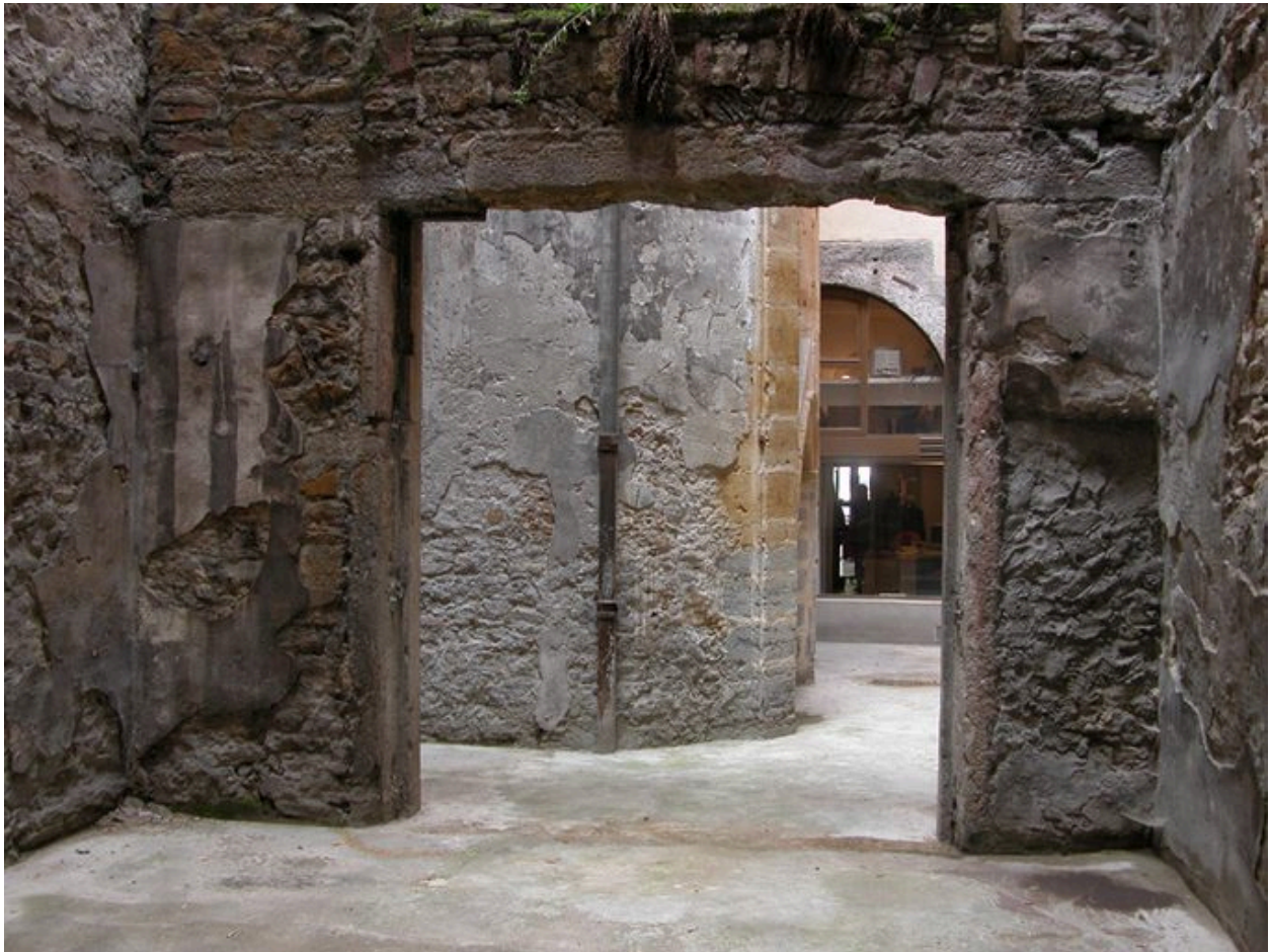
La cour : le rez-de-chaussée
