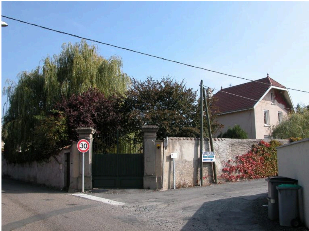
Purelles (les), maison 1986 AL 41 à 44. Maison des années 1920/30, vue d'ensemble depuis la rue;
