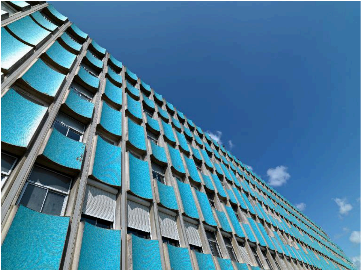
Internat, détail de l'élévation sur cour
