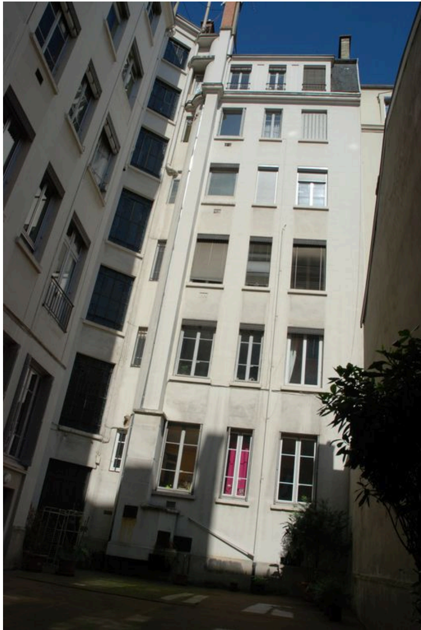
Vue des élévations sur cour
