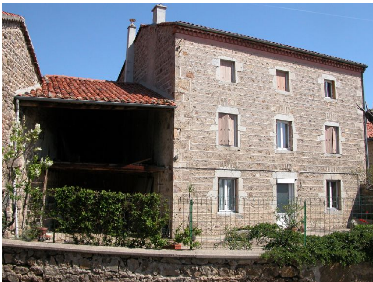
Vue d'ensemble de la façade du logis
