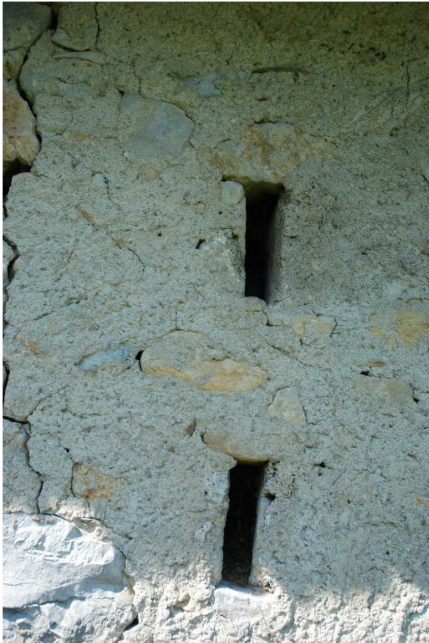
Détail des jours d'aération de placard, en façade arrière.
