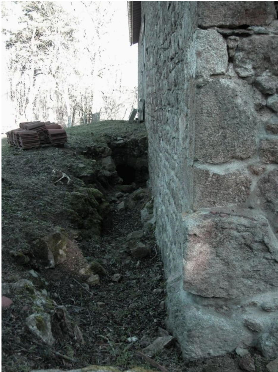
Grange-étable. Vue d'ensemble latérale sud du montoir arrière.
